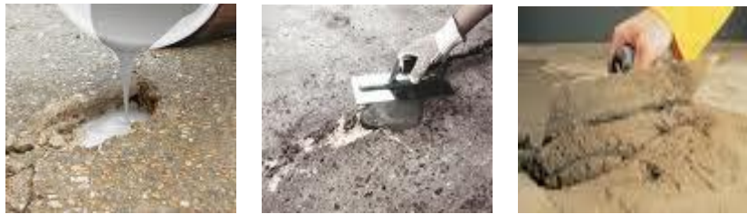
Flüssige Konsistenz oder Mörtelfähige Konsistenz ist individuell einstellbar
